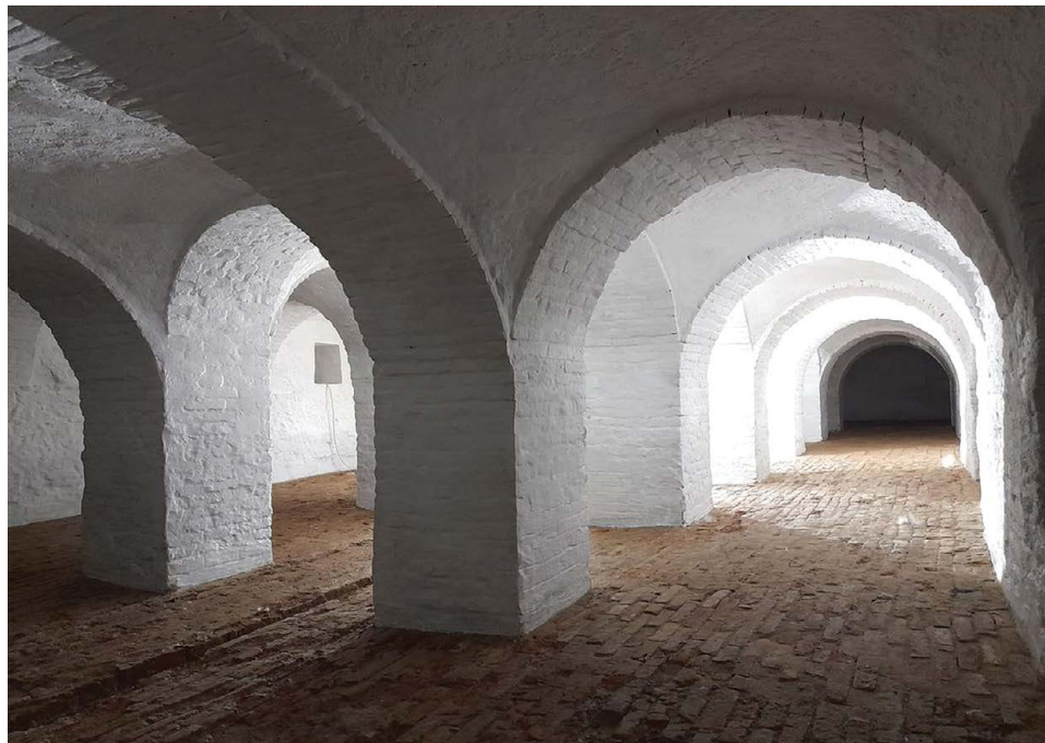
Po 1. etape rekonštrukcie suterénu kláštora
