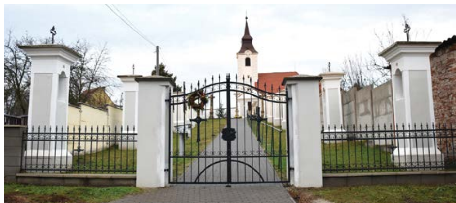
Vstup do kalvárie pred a po oprave
