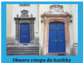
Obnova vstupu do baziliky
