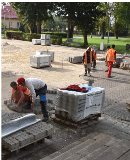
Pred Národnou púťou prebiehali rozsiahle rekonštrukčné práce v celom okolí Baziliky
